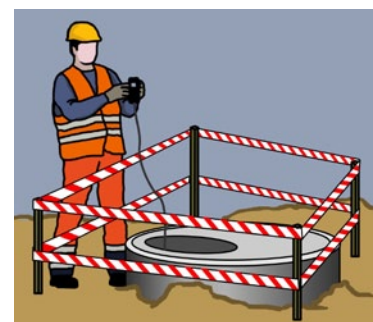
Rys. 3. Wygrozdzenie stref niebezpiecznych
